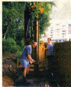
Das sind die kleinen Bohrer für die 16 Probeflöcher in der Lobau.
